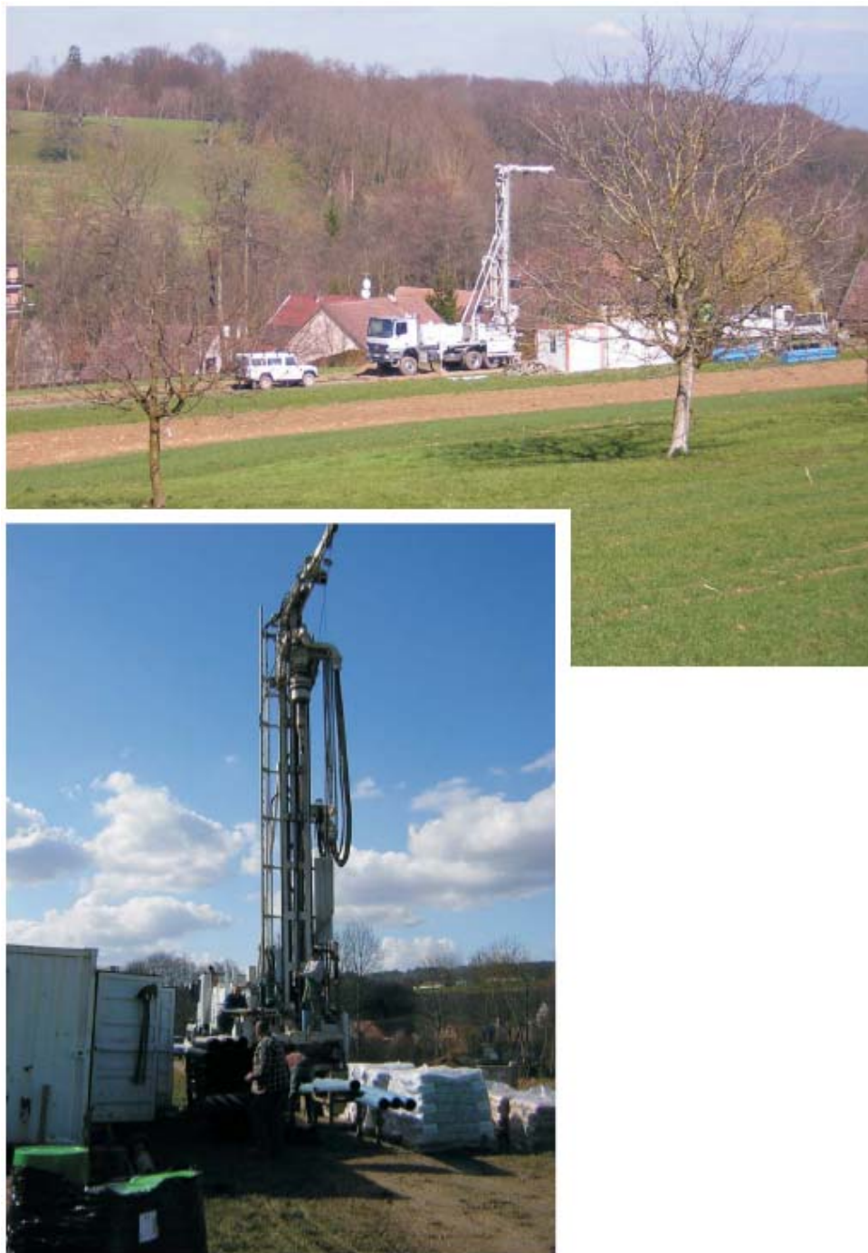
Travaux de forage de Plet9/Plet9bis, aperçu photographique
